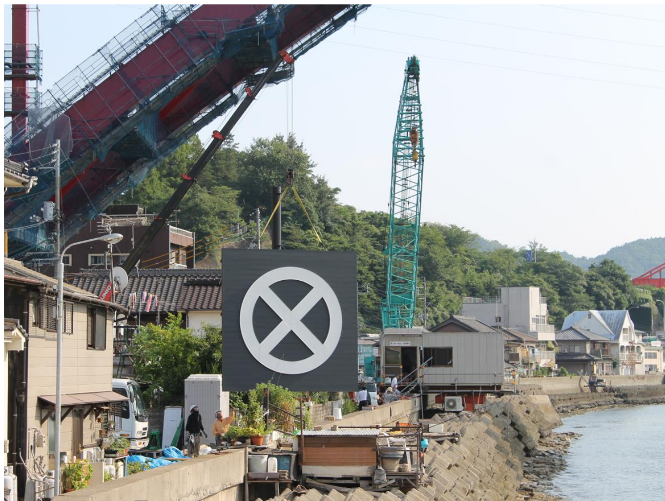
電光表示板の取り外し
