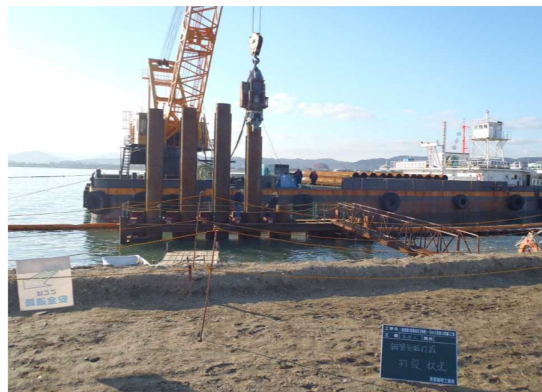
作業状況図 (鋼管矢板施工イメージ)
